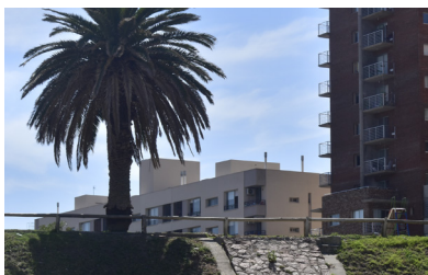
Construcción de plaza y atractivos en Parque Lineal (Barrio Sur)
