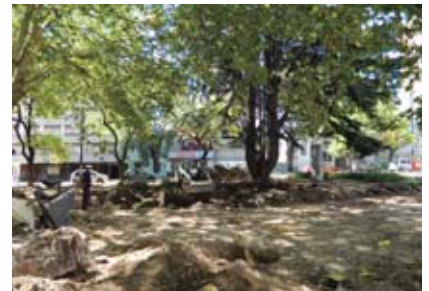
Plaza José Carré en obra
