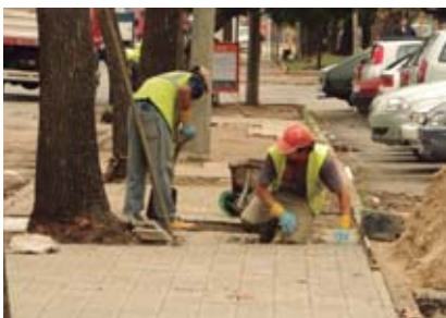
Reparación de vereda
