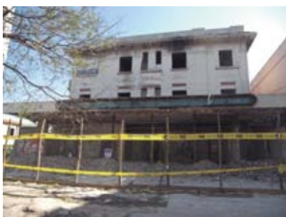
Demolición de COMAEC
