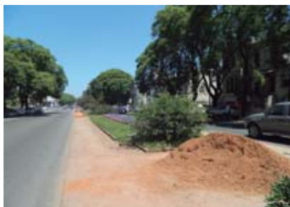
Reparaciones en el cantero de Bvar. Artigas
