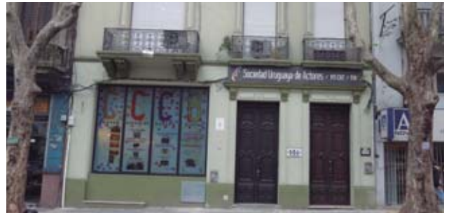
Complejo Cultural Carlos Brussa, perteneciente a la Sociedad Uruguaya de actores (SUA). Obras de reacondicionamiento. Inversión: $ 2.500.000.
